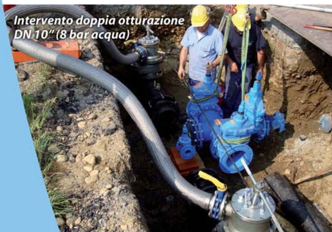
Intervento doppia otturazione DN 10" gas
